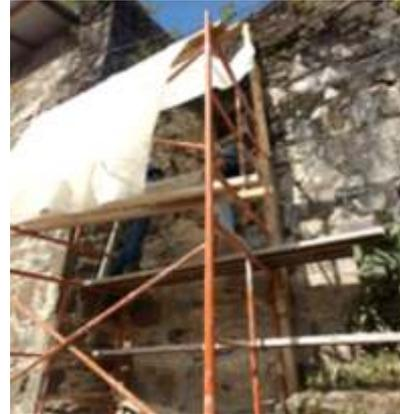
Se realizó la limpieza mediante aire a presión y lavado con agua purificada en áreas liberadas.
