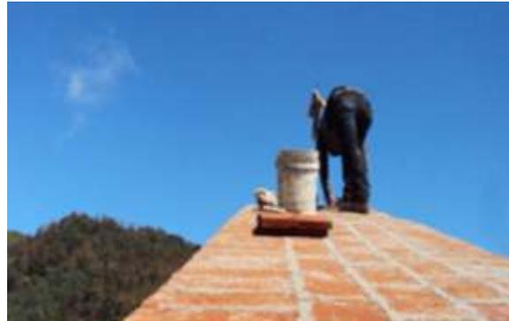
Se continuo con el junteado en enladrillado y en la colocación de impermeabilizante hidrofugante para la protección por intemperismo.
