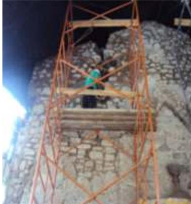
Se realizó la liberación controlada de material dañado o fracturado en portada.
