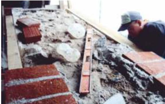
Trabajos de integración de enladrillado en corona de muro para evitar filtraciones al interior del inmueble.
