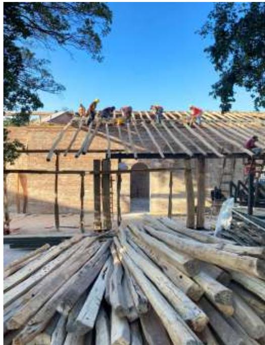
Colocación de murillos para cubierta tradicional de biliguanas,
