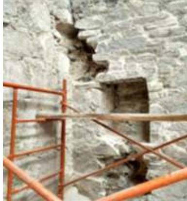
Se realizó la liberación controlada de material dañado o fracturado al interior del inmueble.
