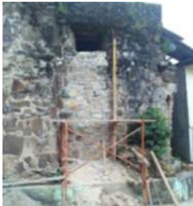
Consolidación de muros con piedra caliza de la región en fachada lateral.
