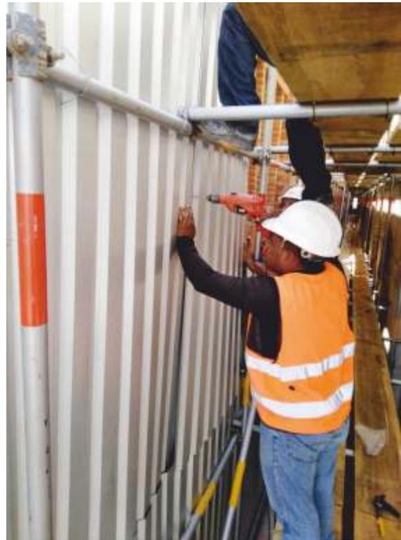
Colocación del tapial con sistema de andamiaje en la fachada posterior
