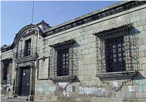
Fachada. Por la ausencia actual de los enclavados, podemos apreciar su sistema constructivo a través de los sillares y la cantera como material constructivo principal. Fotografía del autor
