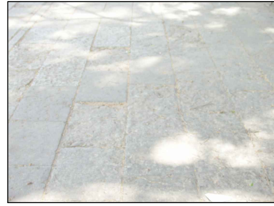
FOTO 3: Imagen que muestra el tratamiento actual de piso en la Alameda de León.
