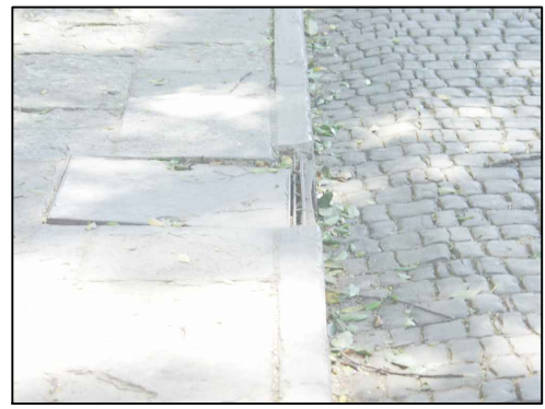
FOTO 9: Tratamiento de piso y cambios de nivel
