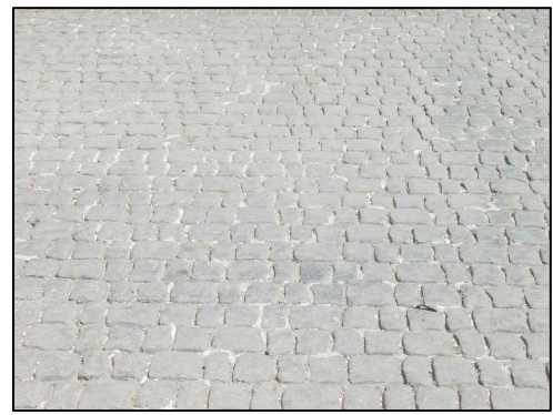
FOTO 7: Tratamiento de piso en arroyo entorno a zocalo.
