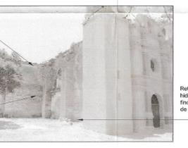
Retiro de piezas fracturadas y reintegración de cejas en pretilos y cornisas de muro poniente de capilla lateral.
