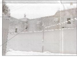
Liberación de material deleznable, reposición de pendientes y enladrillado en contrafuertes de muro oriente de nave en capilla lateral.
