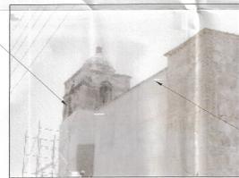
Limpieza de enladrillado, reposición de impermeabilización y pintura a base de almagre en bóvedas y cúpulas de nave de capilla lateral.
