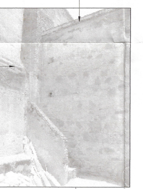
Reintegración de elementos de similar forma, color y textura, y reposición de aplastados base y enmasillado de cal en molduras de escalera de acceso a cubiertas en muro sur.
