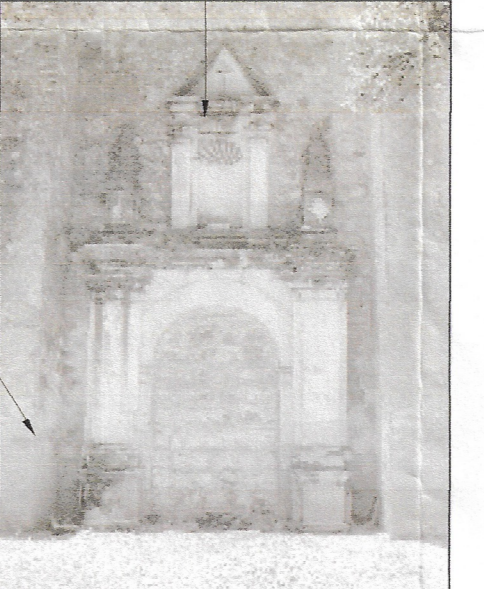
Reintegración de elementos con reposición de piezas de similar color, forma y textura en molduras en base y pino de portada norte de nave principal.
