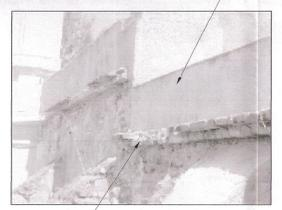
Retiro de piezas fracturadas y reposición de cajas de ladrillo y cornisa en presbitero, en muro sur de coro.
