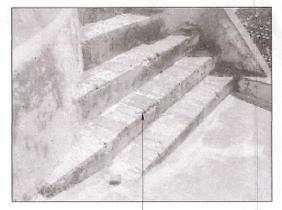
Retiro de piezas fracturadas en escalineros. Limpieza de entablado y reposición de pintura e impermeabilización en cubiertas de presbitero de capilla lateral.
