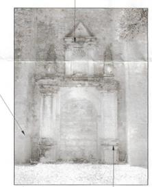
Elementos deteriorados por intemperismo, con aplados recientes empotrados en cemento en desplante en muro norte de nave.
