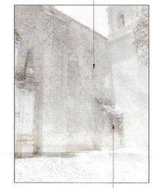
Desprendimiento parcial de piezas de enladrillado en escarpo de contrafuerte de muro norte de coro, evidenciando humedad por escorrentías.
