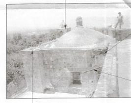
Elementos afectados por intemperismo, y falta de mantenimiento en enladrillado de contrafuerte sin escarpo de muro norte de presbiterio.
