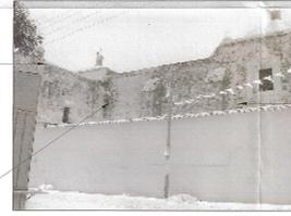
Desprendimiento parcial de enladrillado en contrafuertes de muro oriente de nave en capilla lateral.
