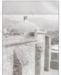
Bajadas de agua pluvial de materiales corrientes e ineficientes en cubierta de nave de capilla lateral.
