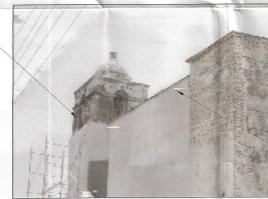
Entortado sin impermeabilización y pintura a base de cal-almagre deteriorado por intemperismo en bóveda de nave de capilla lateral.
