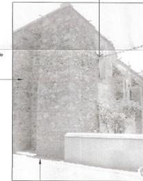
Elementos deteriorados por intemperismo, erosionados por agua y polvo con pérdida de molduras y piezas en moldes y arribo de muro muro norte o testero de presbitero de capilla lateral.
