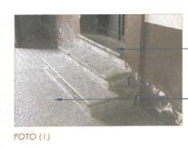
ESCALONES DE PIEDRA CANTERA VERDE, ASENTADA SOBRE UN FIRME DE CONCRETO DE 6 CMS. DE ESPESOR
