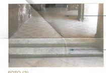
PISO DE LOSETA DE CEMENTO 20x20 CMS. COLOR NATURAL, CON DISEÑO ESTRIBADO, ASENTADO SOBRE UN FIRME DE CONCRETO DE 6 CMS. DE ESPESOR Y JUNTAS A HUESO
