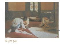
ALFOMBRA COLOR ROJA, ASENTADA SOBRE PISO DE LOSETA DE CEMENTO COLOR ROJO Y AMARILLO CON DISEÑOS GEOMETRICOS, ASENTADO SOBRE UN FIRME DE CONCRETO DE 6 CMS. DE ESPESOR.
