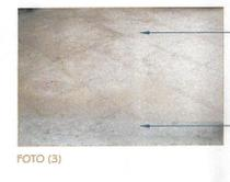
PISO DE CEMENTO COLOR NATURAL, CON DISEÑO GEOMETRICO DE CUADRICULA, ASENTADO SOBRE UN FIRME DE CONCRETO DE 6 CMS DE ESPESOR.
