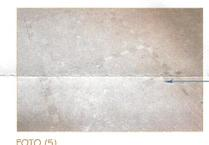
PISO DE LOSETA VINILICA COLOR BLANCA, ASENTADA SOBRE PISO DE LOSETA DE CEMENTO CON DISEÑO CUADRICULADO EN COLORES BLANCO Y NEGRO, SOBRE FIRME DE CONCRETO DE 6 CMS. DE ESPESOR.
