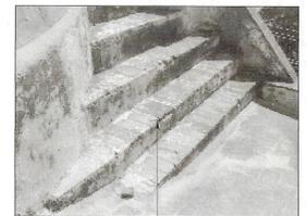
Desprendimiento parcial de piezas de enladrillado en escalonamientos en cubierta, falta de impermeabilización y pintura en cubiertas de presbitero de capilla lateral.
