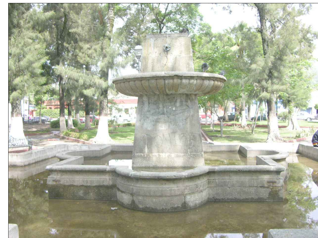
DETALLE DE LA PARTE CENTRAL DE LA FUENTE.
