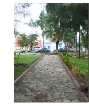
FOTO 6 PISO EN PASILLOS INTERIORES QUE PRESENTA DAÑOS POR DESGASTE NATURAL, PERDIDA DE PIEZAS, FRACTURAS Y ASENTAMIENTOS DE TERRENO
