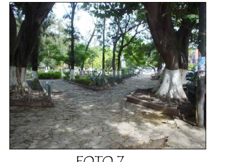
FOTO 7 ACCESO A JARDIN QUE PRESENTA DAÑOS EN PISO, JARDINERAS, Y VEGETACION
