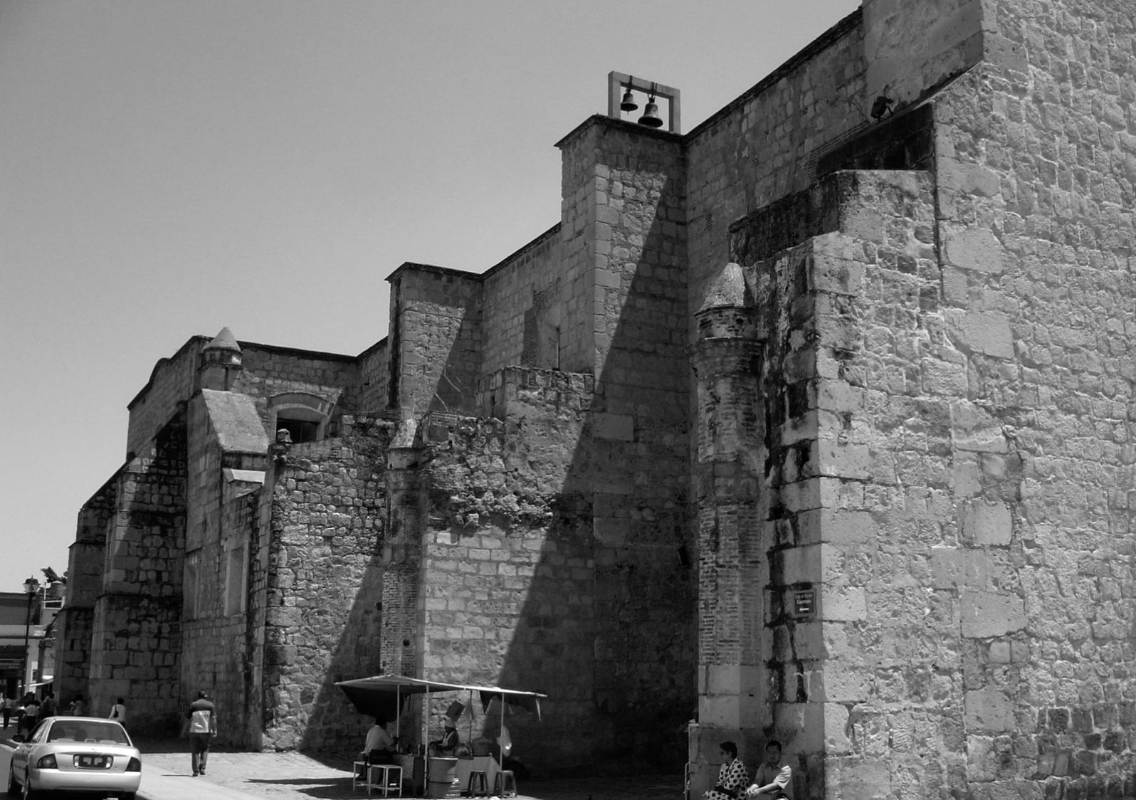
Fachada lateral norte del templo. Nótese el estado de los sillares de cantera y el campanil agregado ubicado sobre el contrafuerte. / INPAC. 2007
