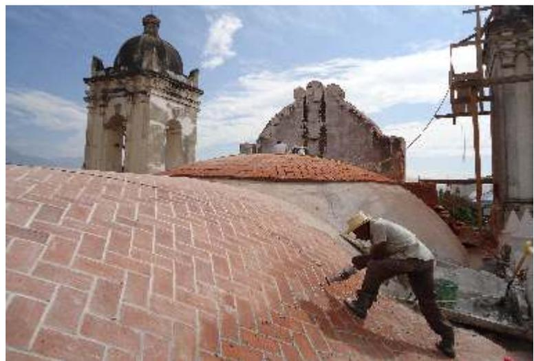
*Colocación de enladrillado tipo petatillo en extradós de bóveda / Archivo INPAC*
