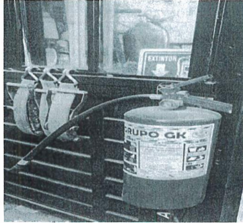
Fig. 4 Segundo extintor contra incendios en el centro de acopio del C. JOSÉ ÁNGEL JUÁREZ GARCÍA
