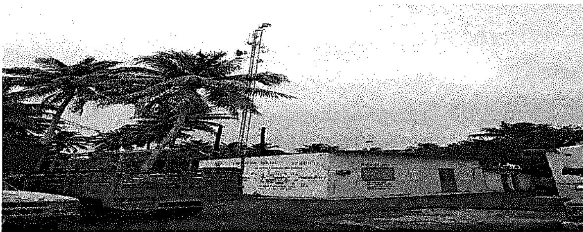
BIBLIOTECA PÚBLICA DE LA AGENCIA DE FRANCISCO VILLA E INSTALACIONES DE INTERNET SATELITAL.
