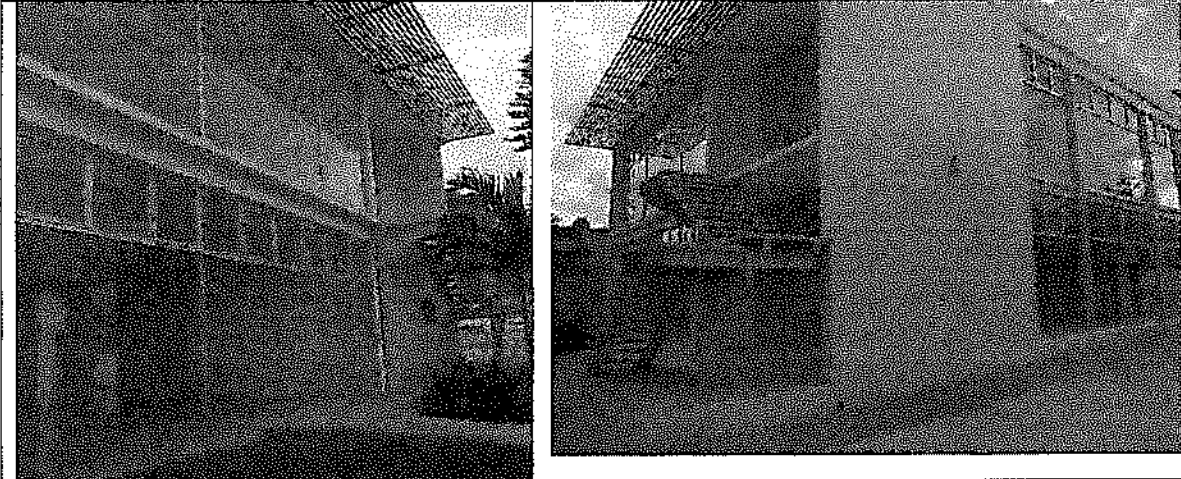
Visita de inspección técnica higiénica y pedagógica al Colegio de Estudios Superiores y de Especialidades del Estado de Oaxaca, Campus Puerto Escondido
