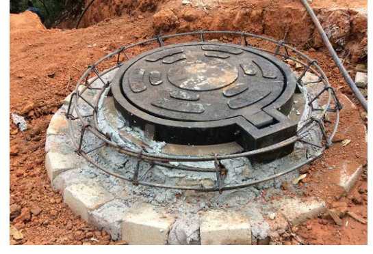
ARMADO DE BROCAL SIN ESC.
