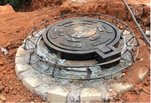
ARMADO DE BROCAL SIN ESC.
