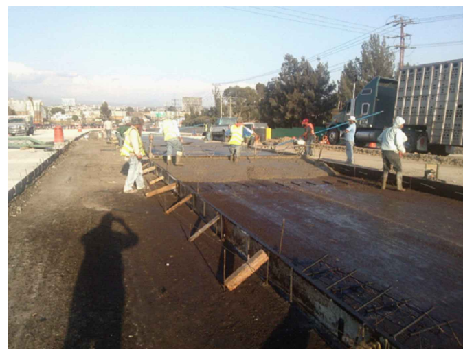
COLOCACION DEL CONCRETO, DETALLE 'E'
