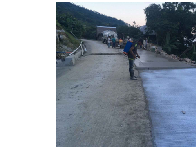
Colocación de una membrana de curado con una bomba de aspersión manual, inmediatamente despues del texturizado una vez que ya se haya evaporado el agua superficial.
