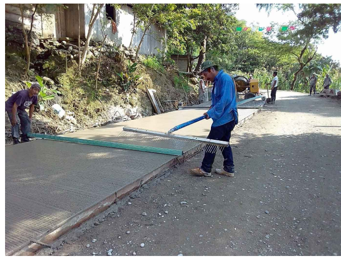
TEXTURIZADO de la superficie utilizando el Texturizador ayuda a una mayor fricción, se aplica en el concreto cuando aun esté en estado plastico, de manera que los cerdas del peine penetren a una profundidad mínima aproximada de 3 mm pero nunca mayor de 5 mm sobre la superficie
