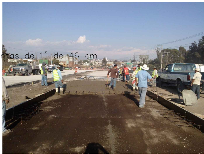
DETALLE 'C' COLOCACION DE LAS BARRAS PASAJUNTAS DE 1" DE 46 CM LONG Y COLOCACION DE CMBRA SIN ESC.
