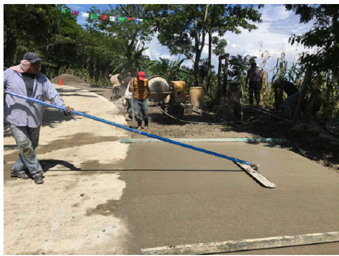
FLOTA. Tiene la función de afinar el concreto y traer de manera uniforme a la superficie los finos.
