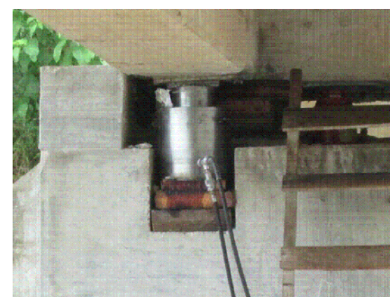
NICHOS DE IZAJE PARA COLOCACION DE GATO HIDRAULICO PARA CAMBIO DE PLACAS DE NEOPRENO
