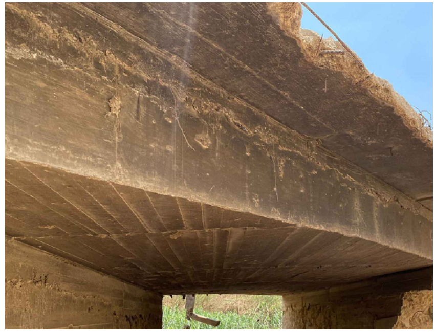
VISTA DE GRIETAS EN LOSA MACIZA
