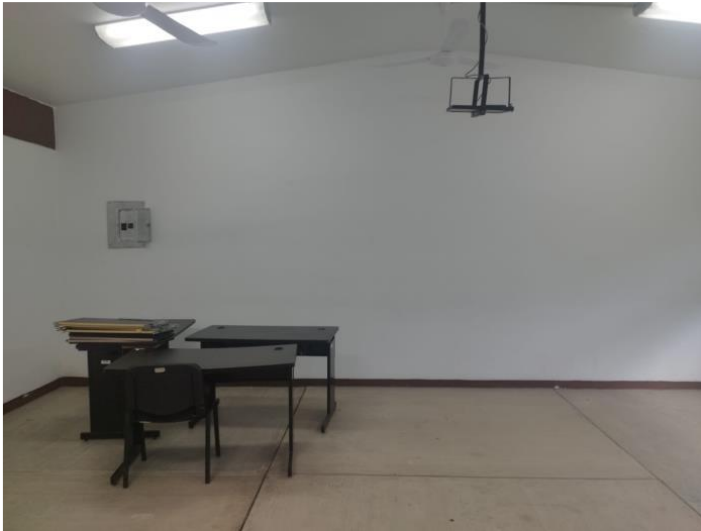
Muro en donde se ubicará el equipo
